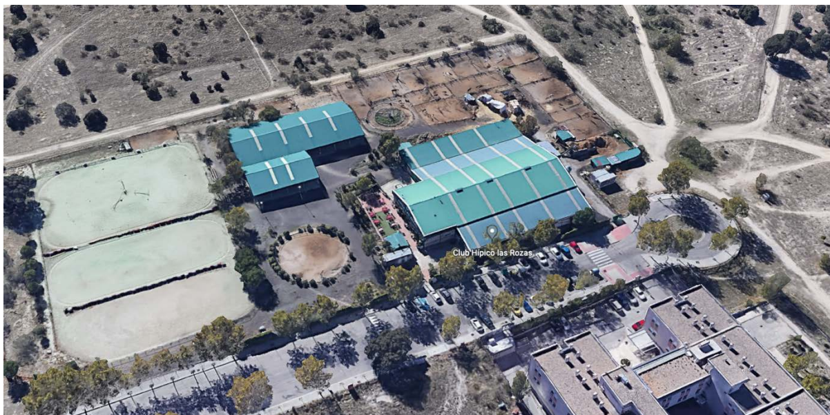
Figura 6. Vista general de la Escuela Municipal de Hípica.
