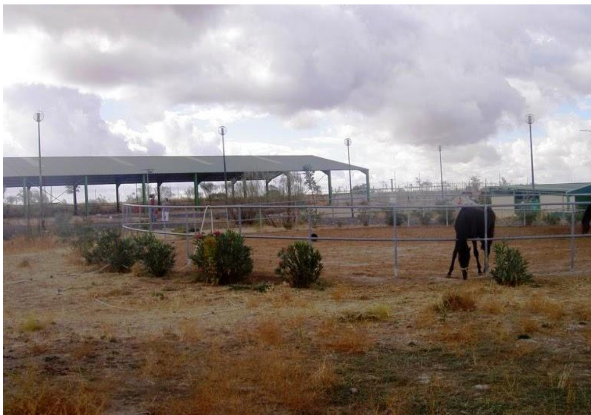
Figura 1. Instalaciones deportivas de la Escuela Municipal de Hípica.
