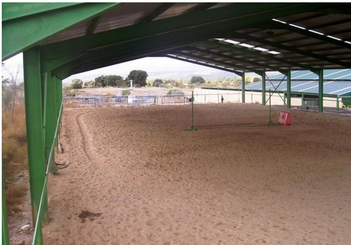
Figura 2. Instalaciones deportivas de la Escuela Municipal de Hípica.
