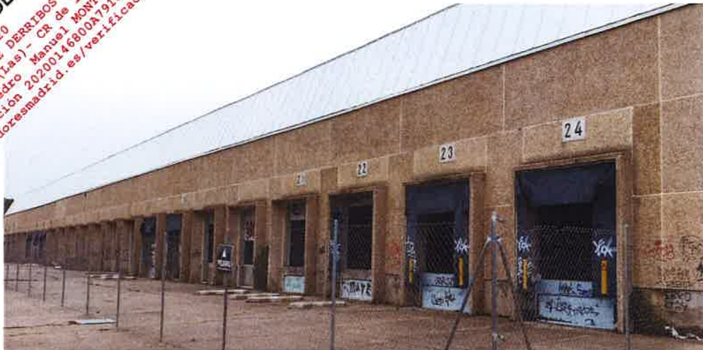
NAVE PRINCIPAL. FACHADA OESTE
