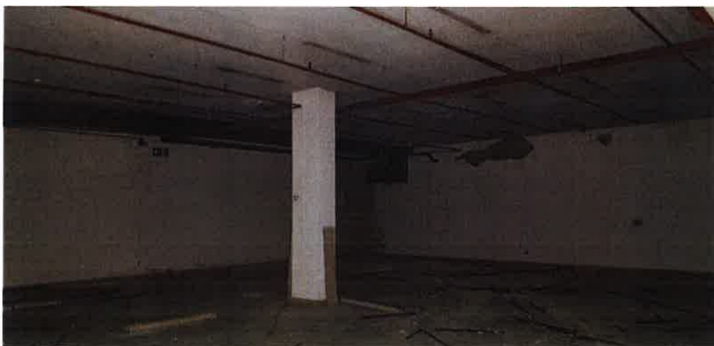
INTERIOR DE EDIFICIO DE CONEXIÓN
