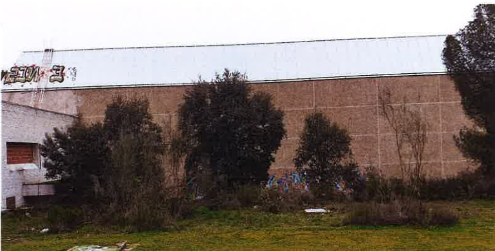
NAVE PRINCIPAL. FACHADA NORTE
