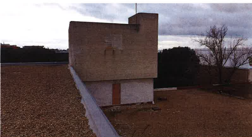
EDIFICIO CONEXIÓN. CUBIERTA
