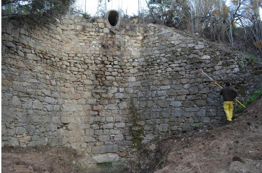
Figura 23: retirada mediante pértiga la vegetación adherida a los paramentos.
