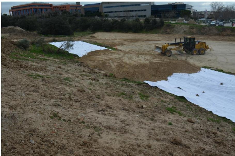
Figura 17: cubrición del geotextil
