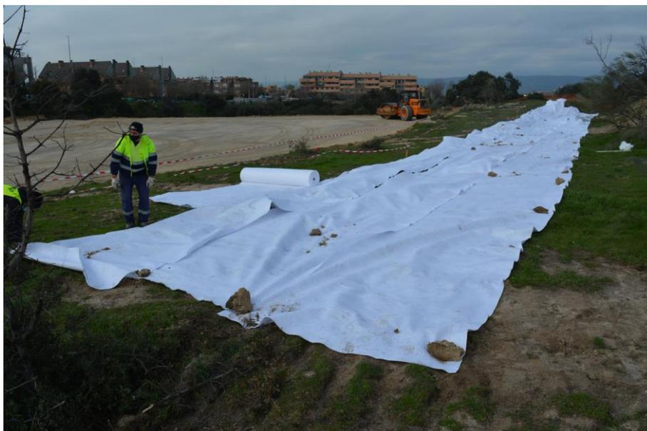
Figura 15: trabajos de cubrición del Canal con geotextil.
