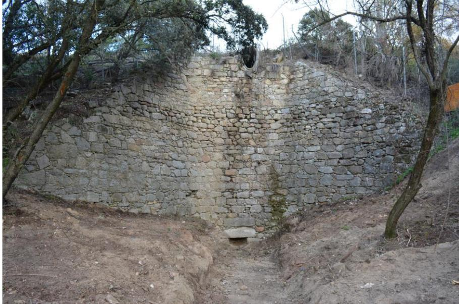
Figura 27: el acueducto de fábrica tras finalizar los trabajos de limpieza.
