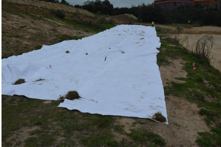
Cubrición con geotextil del Canal del Guadarrama y del Camino de sirga en la zona proyectada para la prolongación de la calle Gabriela Mistral. Sobre el geotextil se están instalando las acometidas de agua.
