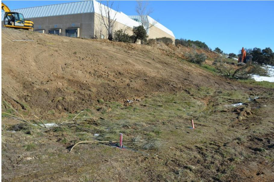
Figura 12: estacas en la traza central del Canal. Detrás el talud de la casa kodak que creemos que sepulta parte del Canal.
