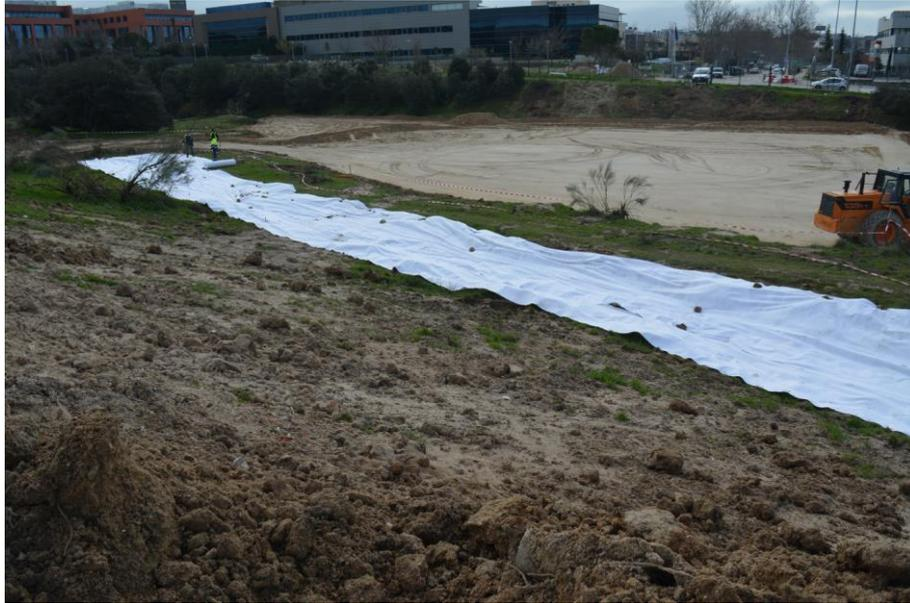
Figura 16: trabajos de cubrición del Canal con geotextil. Al fondo la colmatación del barranco para la prolongación de la calle Gabriela Mistral
