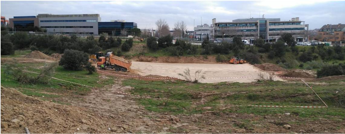
Figura 14: comienzo de la colmatación con arenas de la vaguada para conformar la calle Gabriela Mistral. En medio el Canal balizado.
