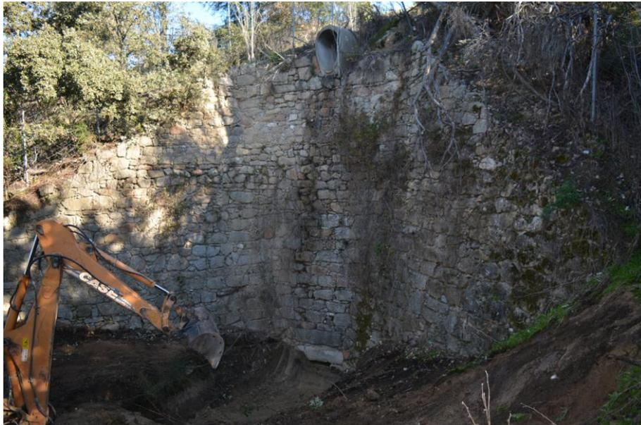
Figura 22: retirada con cazo de limpieza de la tierra vegetal que taponaba la alcantarilla bajo el acueducto.
