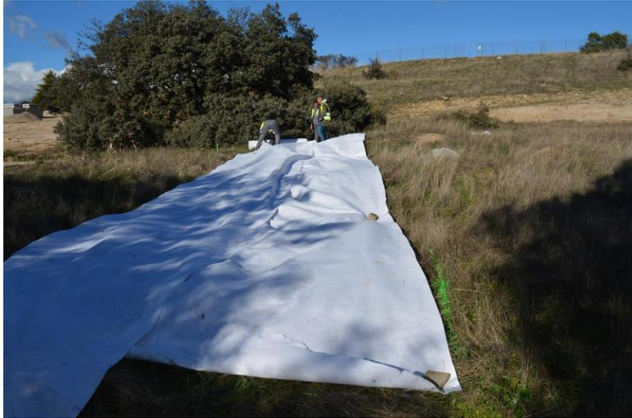
Figura 18: cubrición del geotextil el tramo más próximo a la calle Adolfo Pérez Esquivel. En esta zona no se observa la traza del Canal. Asimismo, junto al talud de la calle Adolfo Pérez Esquivel ha sido destruido por escorrentía del barranco.
