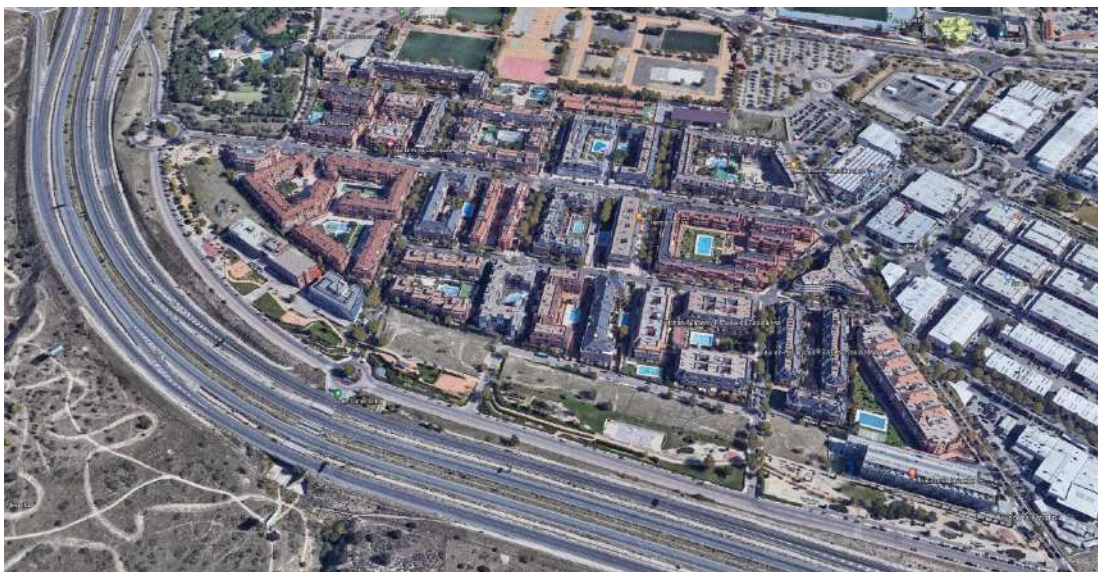
FIGURA. 13. SITUACIÓN ACTUAL DEL ÁMBITO DE LA MODIFICACIÓN PUNTUAL. FUENTE: GOOGLE EARTH®.
