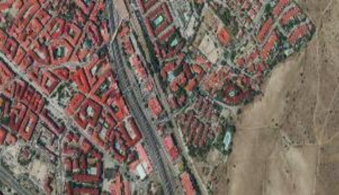
Riesgo de incendio urbano en el interior
